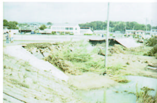
勇崎漁港南堤防法裏崩落
