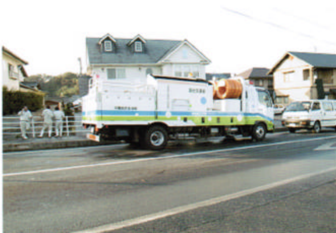
倉敷市玉島勇崎地内、排水作業の状況
