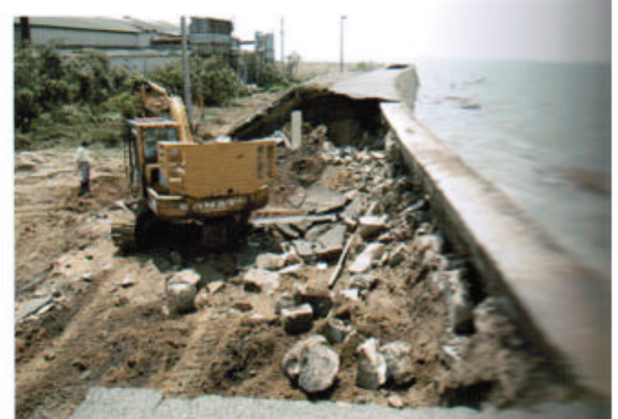
倉敷市玉島勇崎地内、防潮堤被災の様子
