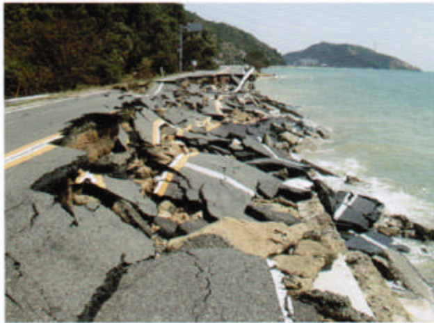
倉敷市・玉野市境界付近、道路被災状況
