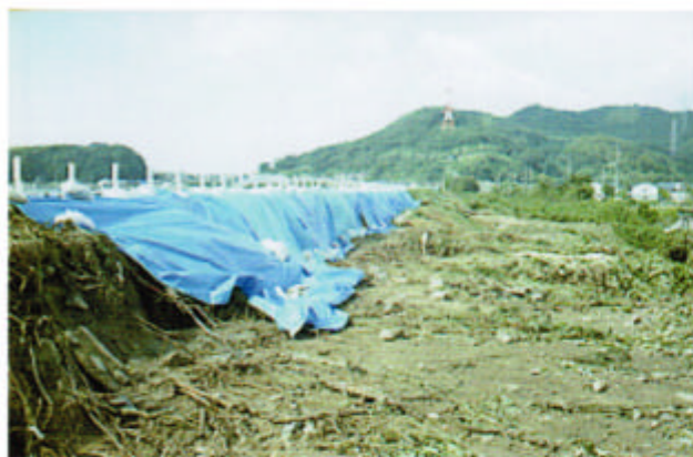
小原漁港北堤防法裏崩落
