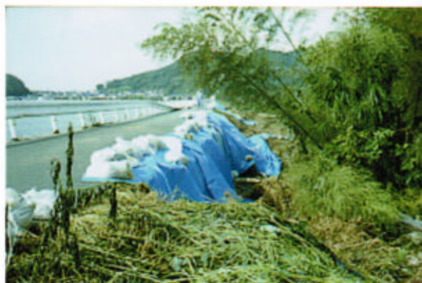
小原漁港北堤防法裏崩落
