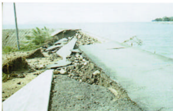
勇崎漁港南堤防法裏崩落
